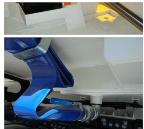
Vista interior del depósito y vista exterior de la manguera de drenaje
