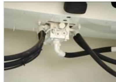
Bloc hydraulique 2 situé sur la porte arrière
