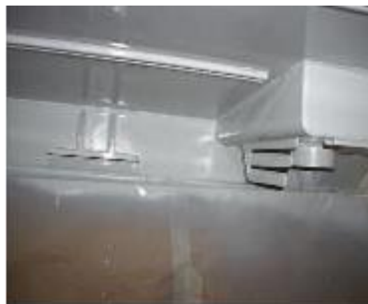
Peinture et étanchéification sous la benne
